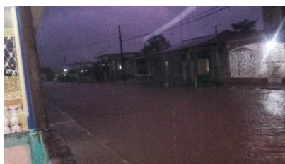
Insuficiente drenaje en Camajuaní.
