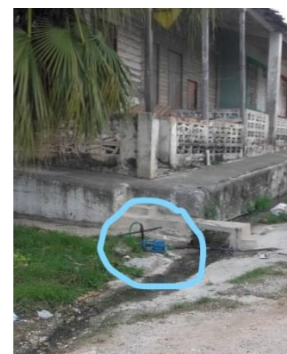
Los camajuanenses están obligados a instalar turbinas para poder acceder al agua. En ocasiones se produce competencia, de modo que algunos se quedan sin agua por la caída de la presión.
