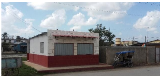
De reciente construcción, ha operado con intermitencia, pero finalmente cerró.
