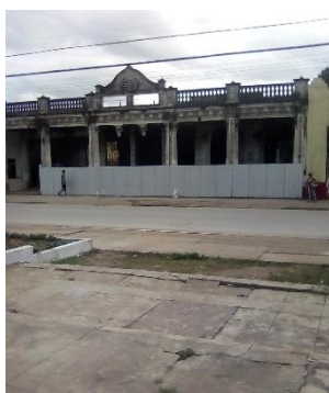
Hotel Las Tullerías, lleva decenas de años abandonado. Está situado frente al parque municipal.
